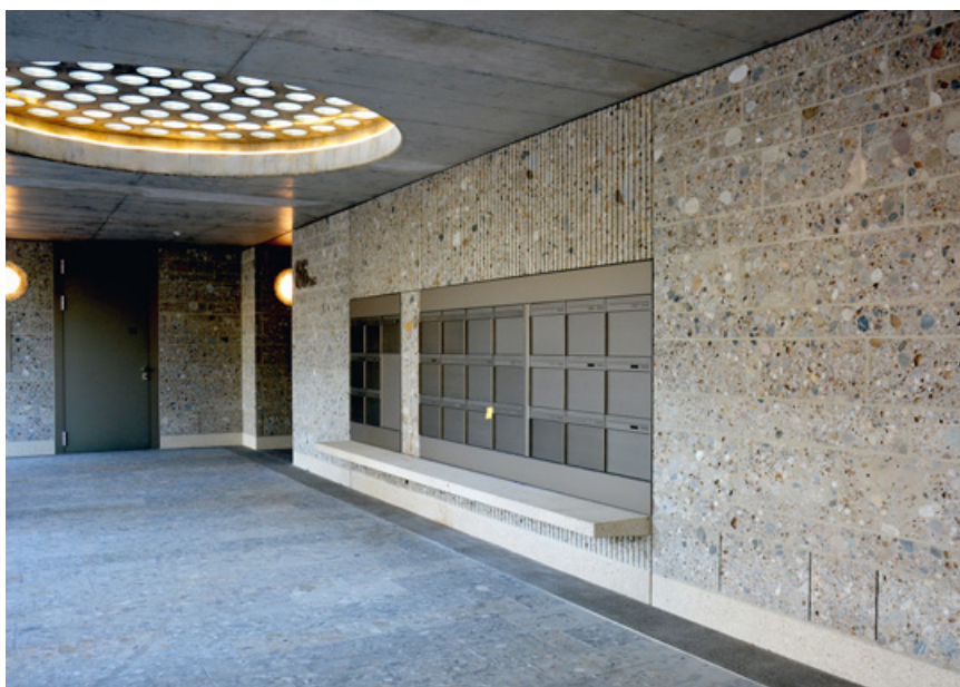
Fassadenausschnitt mit der grobkörnig strukturierten BRANNENBURGER NAGELFLUH
