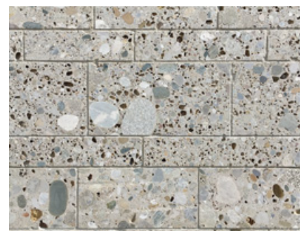
Fassadenausschnitt mit der grobkörnig strukturierten BRANNENBURGER NAGELFLUH
